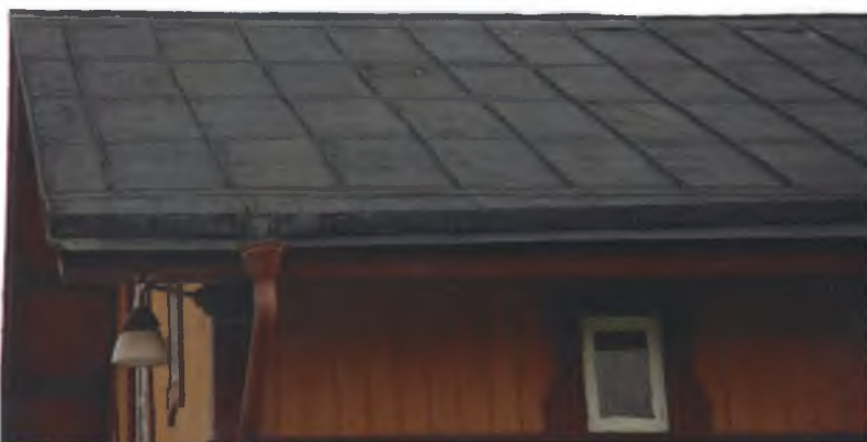
Plåttak innan omläggning. Vlm_kmvLS-654
