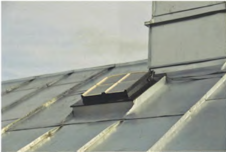
Renoverat och upphöjt takfönster. Vlm_kmoLS-2354
