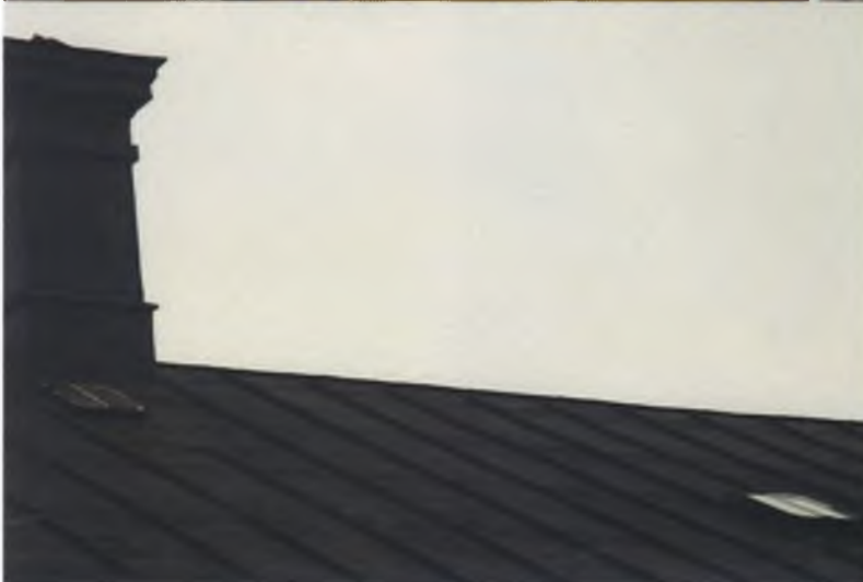
Takfönster innan åtgärder. Vlm_kmvLS-656
