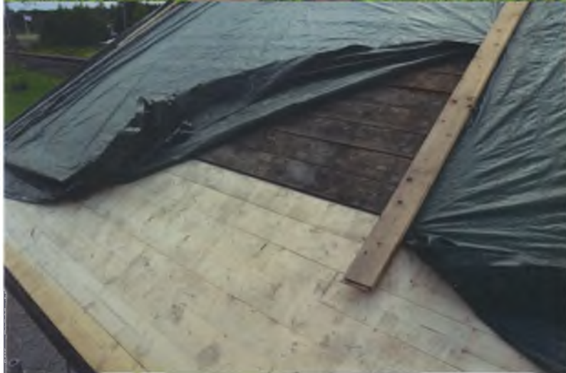
Lagningar av undertak på norra takfallet. Vlm_kmvLS-1973
