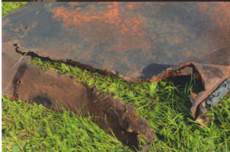
Bit av nedtagen takplåt med rostig undersida. Vlm_kmvLS- 1967
