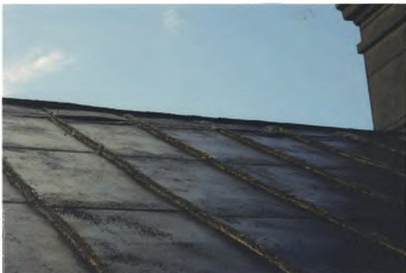
Plåttak innan omläggning. Vlm_kmvLS-1709
