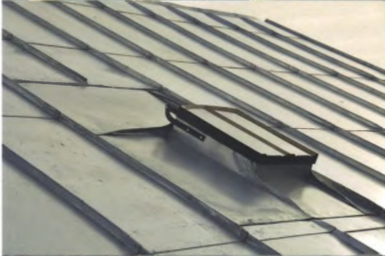
Renoverat och upphöjt takfönster. Vlm_kmoLS-2356
