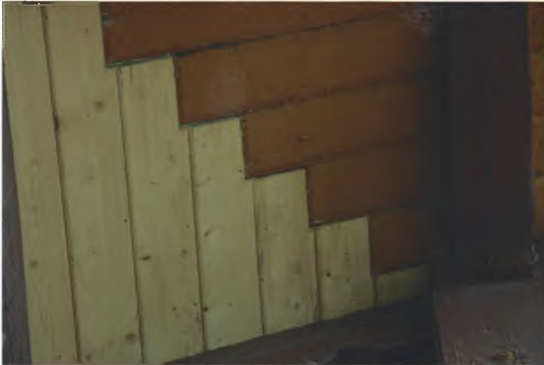
Lagningar av undertak på norra takfallet. Vlm_kmvLS-1972
